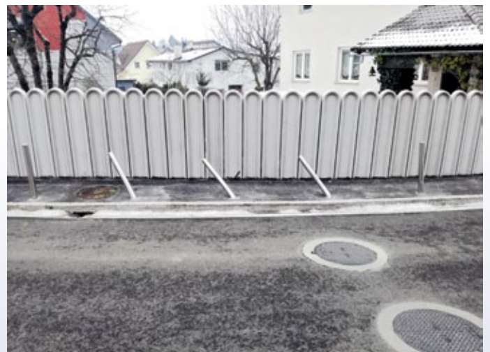
Že v prvih urah po odprtju ceste je prišlo do poškodbe cestne opreme.
