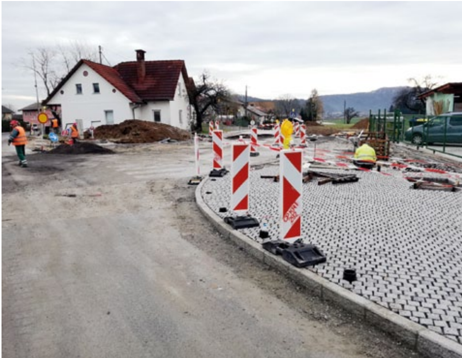
Rekonstrukcija križišča in prestavitev prehoda za pešce.
