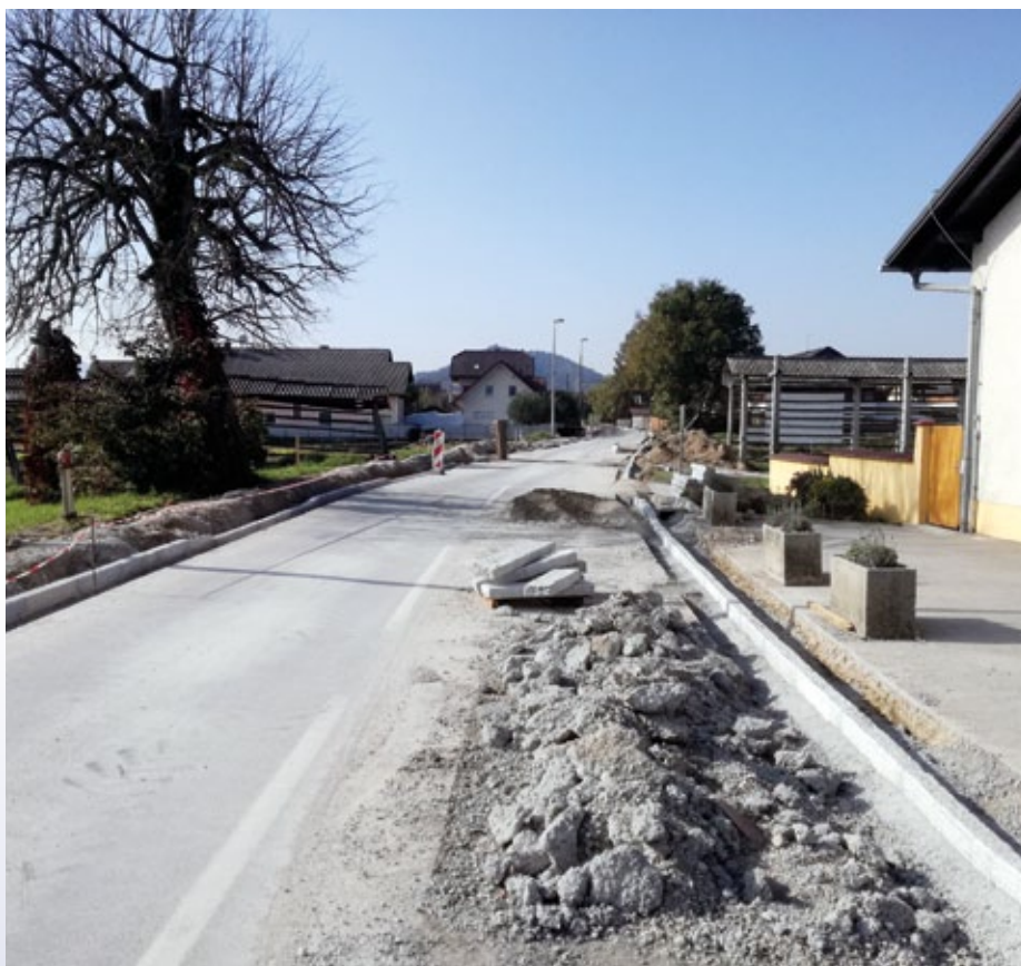
Betonski robniki so se v sklopu rekonstrukcije nadomestili z granitnimi.
