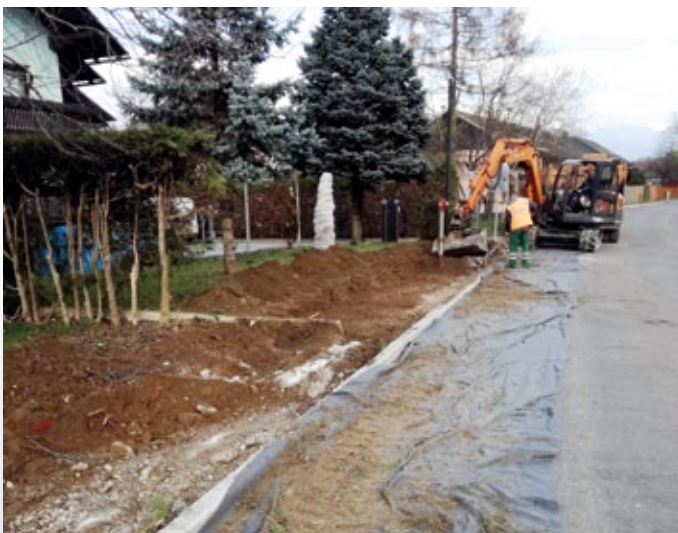
Izgradnja pločnika Ob Grabnu.
